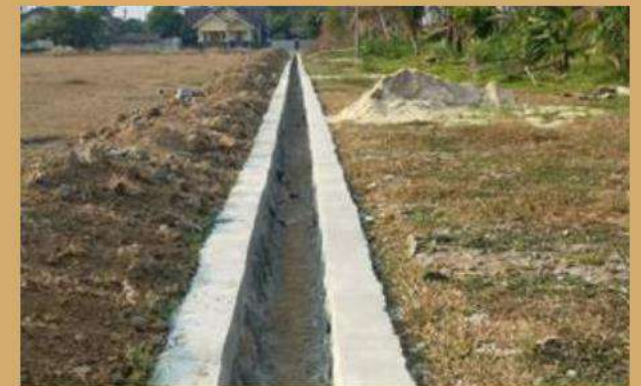
Pembangunan Saluran Drainase Jl. Gembira Kel. Sumbersari
