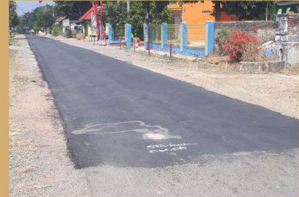
Rehabilitasi Jl. Langsung Kel. Yosomulyo Kec. Metro Pusat
