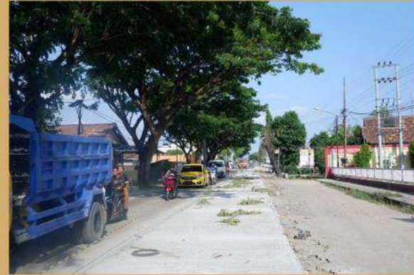
Peningkatan Jalan Pada Ruas Jl. Sultan Shahrir
