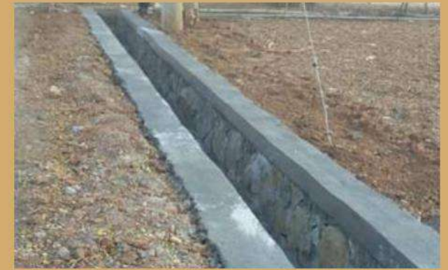
Pembangunan Saluran Drainase Jl. Adipati II Kel. Margorejo
