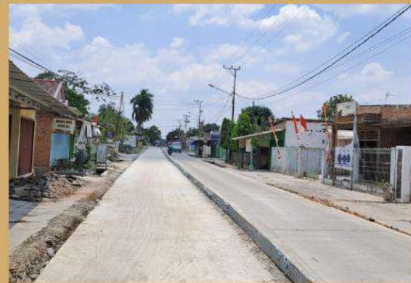
Peningkatan Jalan Pada Ruas Jl. Hassanudin
