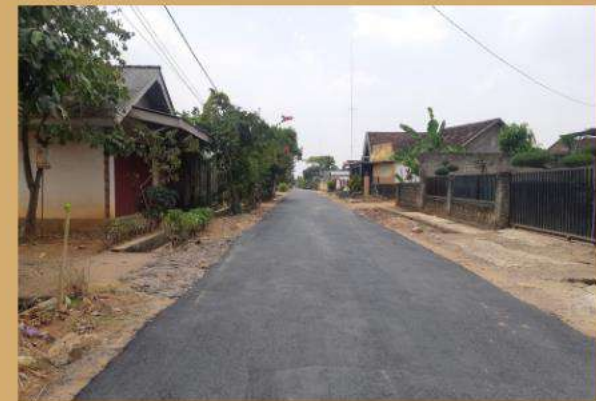
Rehabilitasi Jalan Pada Ruas Jl. Cendrawasih Kec. Metro Utara
